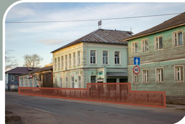
Перенасыщение типовыми ограждениями
