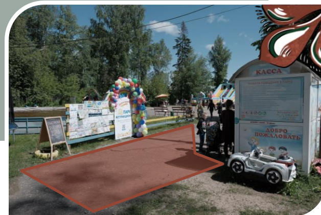
Плохое состояние покрытий
