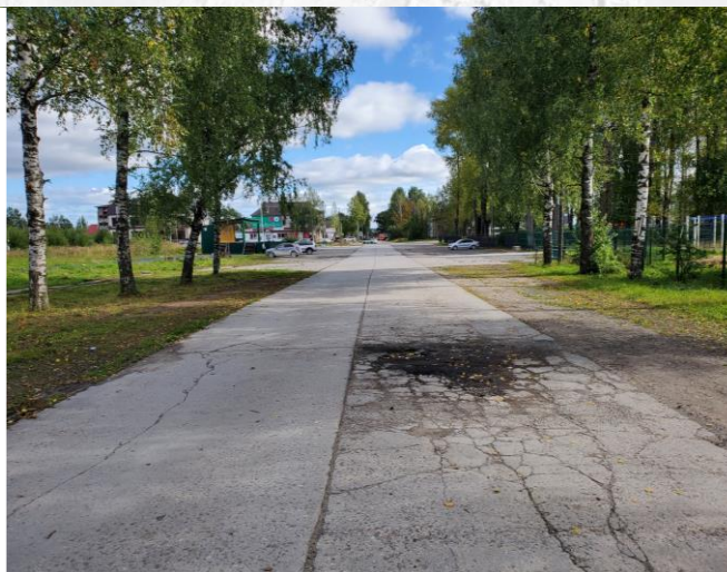
Отсутствие освещения на бульваре
