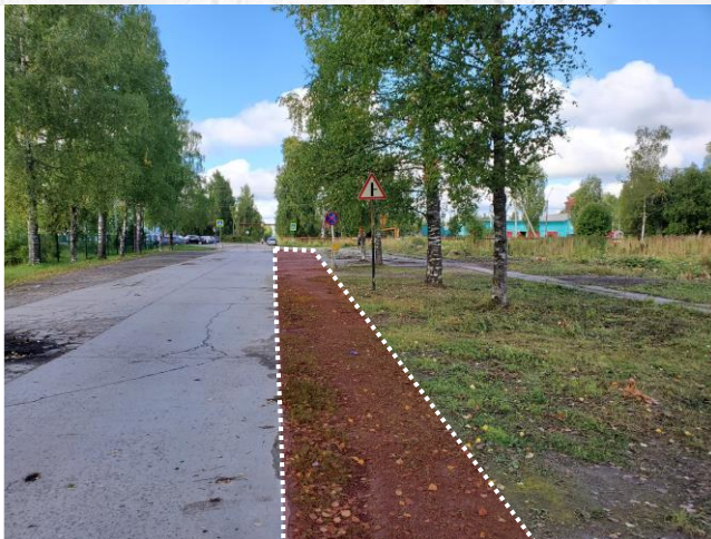
Отсутствие освещения на бульваре
