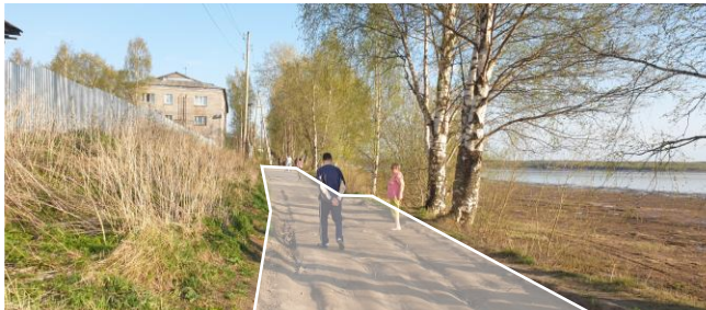
Отсутствие твердых покрытий части набережной
