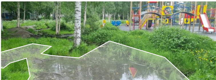
Отсутствие твердых покрытий, подтопляемость территории
