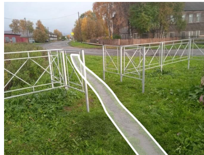
НЕТ ТВЕРДЫХ ДОРОЖНЫХ ПОКРЫТИЙ
