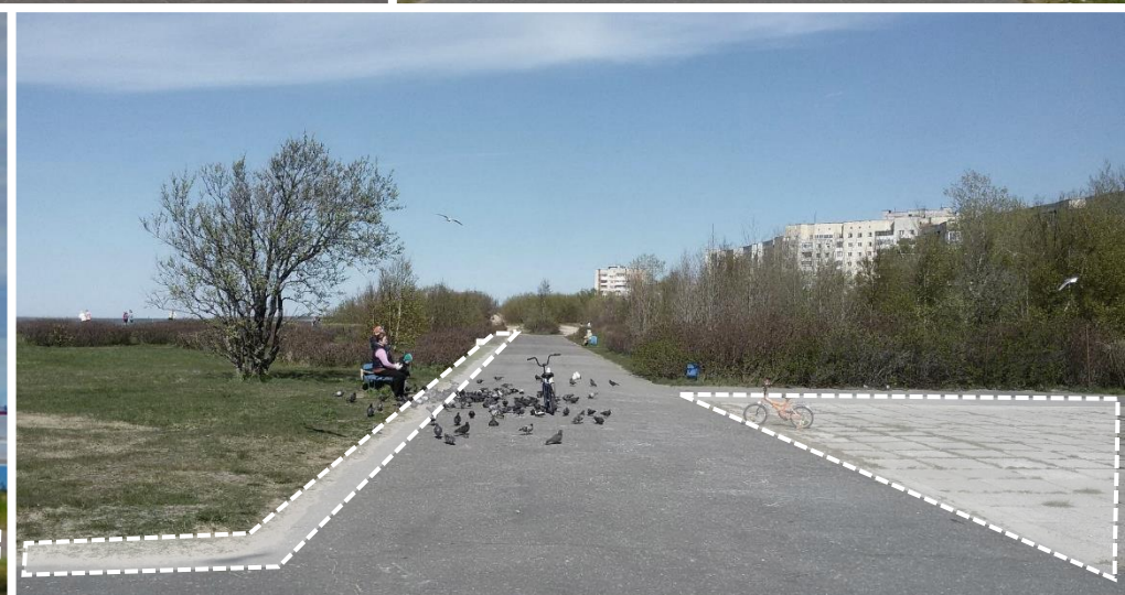
Плохое состояние твёрдых покрытий и отсутствие бортовых камней
